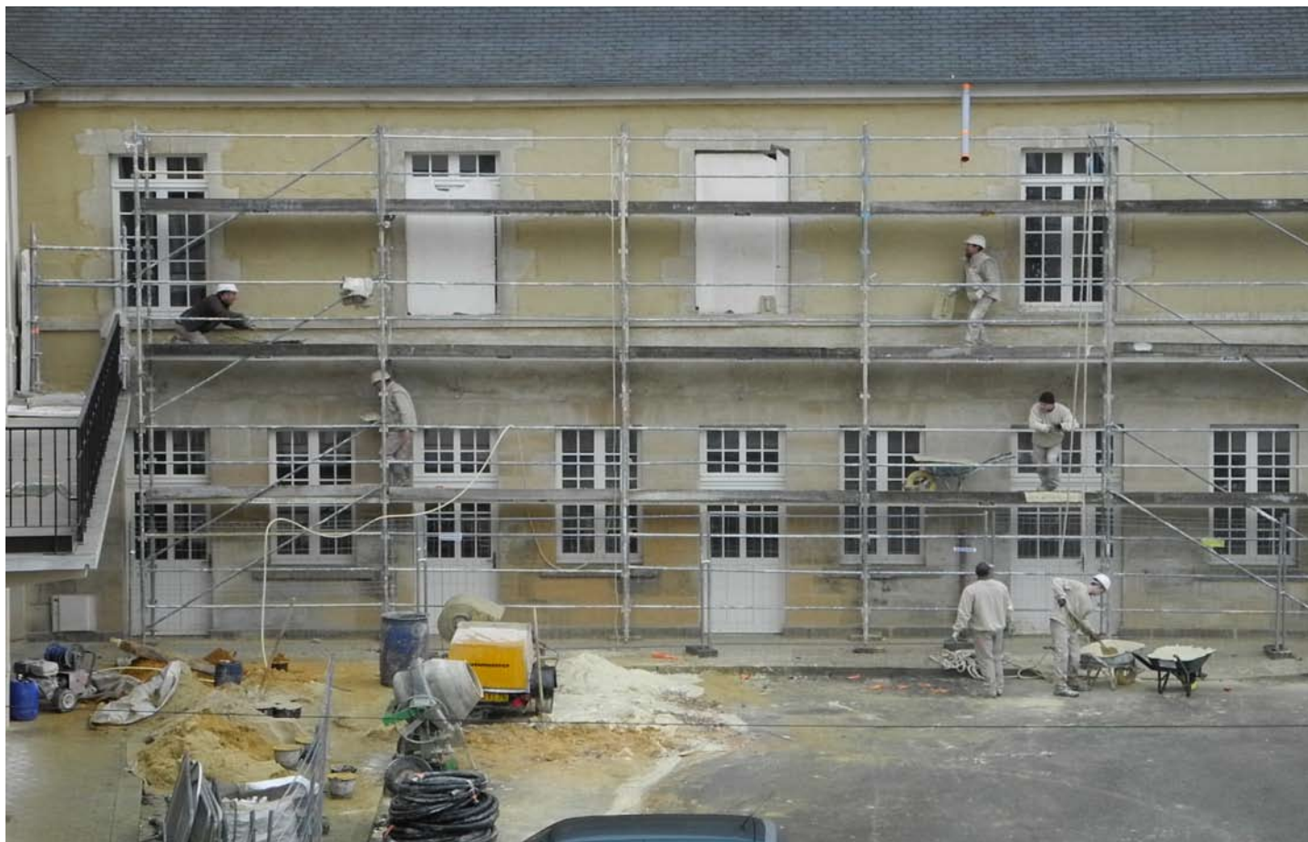
Notre plus gros chantier avec une réalisation en deux tranches : l'ancien collège dont les derniers élèves sont partis en 1968.
